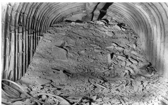
Рис. 3 Выброс породы при взрывных работах во 2-м южном квершлага шахты «Щегловская - Глубокая».
